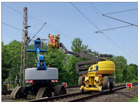
接触线施工
