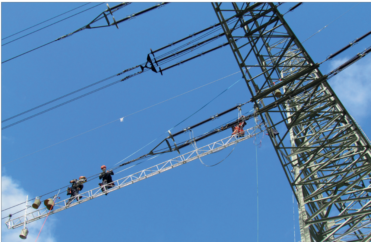
空架线路施工
